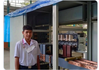
ตู้ไฟฟ้าระหว่างประกอบ
