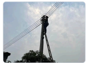
ขึ้นเสาเพื่อเดินสายกล้อง
