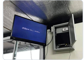
จอแสดงผลและตู้อุปกรณ์ได้หลังคา
