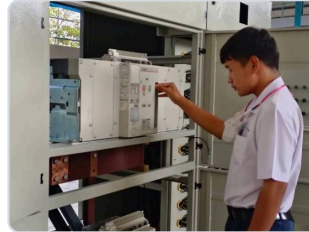
ตรวจอุปกรณ์ในตู้ไฟฟ้า
