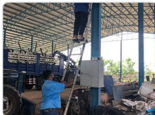
ติดตั้งอุปกรณ์บนที่สูงในโรงงาน
