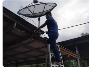
ติดตั้งงานใต้ชายคา
