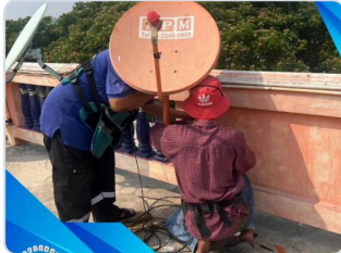
ติดตั้งจานดาวเทียมบนดาดฟ้า
