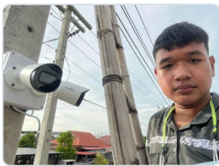
ติดตั้งกล้องวงจรปิดบนเสาไฟนอกอาคาร
